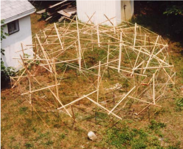
Fig.4. Cúpula tensegrítica 8v de doble capa realizada por Burkhardt
