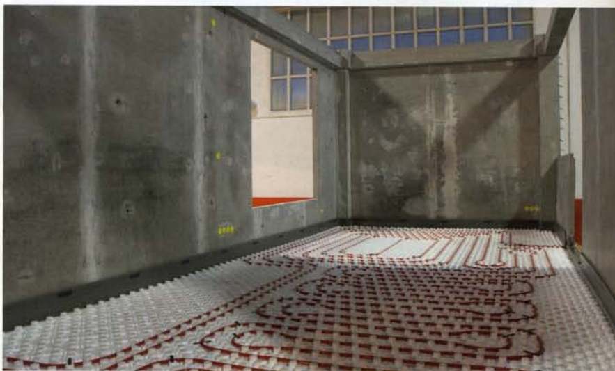
Modul mit integrierter Fußbodenheizung vor dem Glätten
